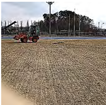
写真1 大型鉄製レイキをトラクターでけん引している不陸整正状況、遠景 <インフィールドクレイグラウンド>
